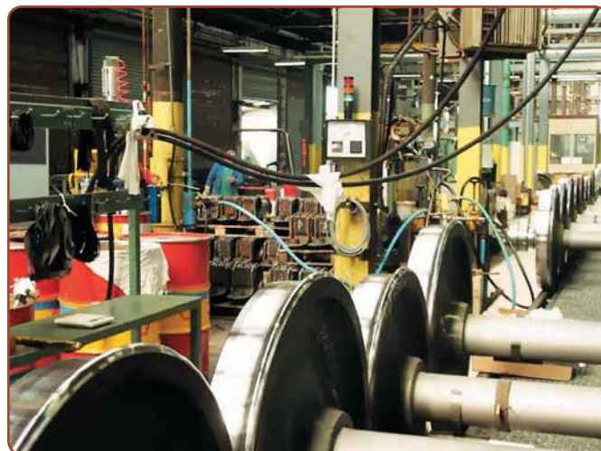
Рис. 1. Фото установки заправки смазки в колесные пары в депо
