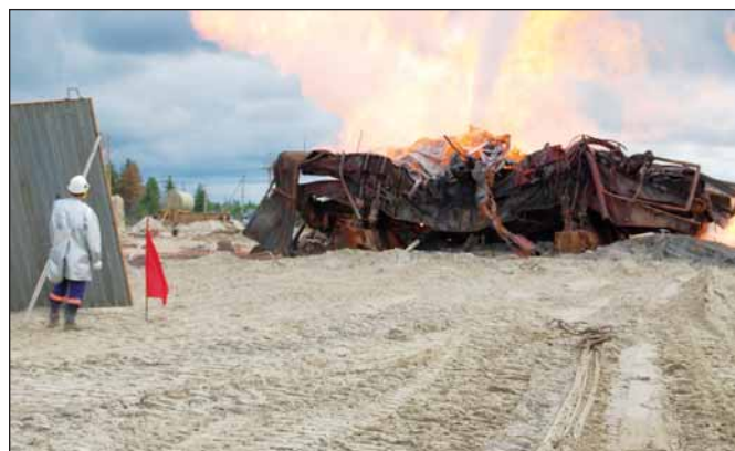
Рис. 4 Буровая установка БУ-3200/200 ЭУК после возникновения открытого газового фонтана
