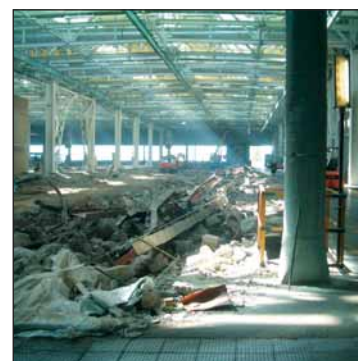
Цех КАМАЗа с вскрытым полом
