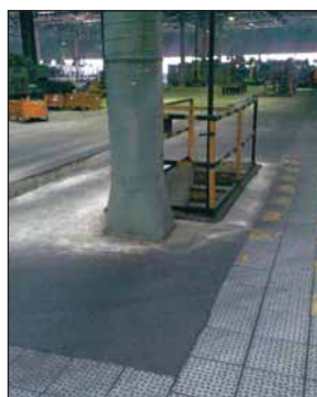
Цех КАМАЗа до начала работ
