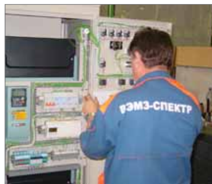
Рис. 2. Монтаж шкафов управления
