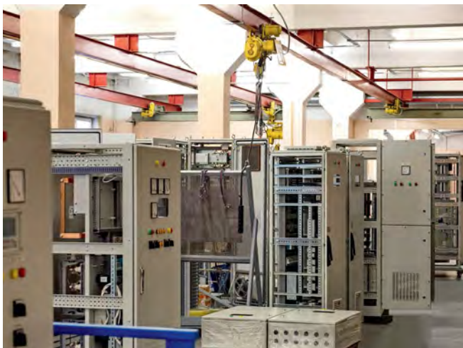
Фото 3. Сборочный цех систем возбуждения и систем управления возбуждением синхронных генераторов
