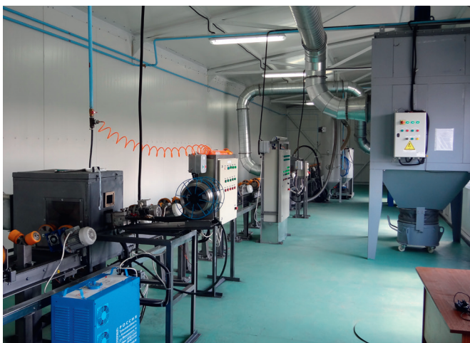
Рис. 3. Автоматизированная линия для нанесения металлических покрытий методом электродугового напыления
