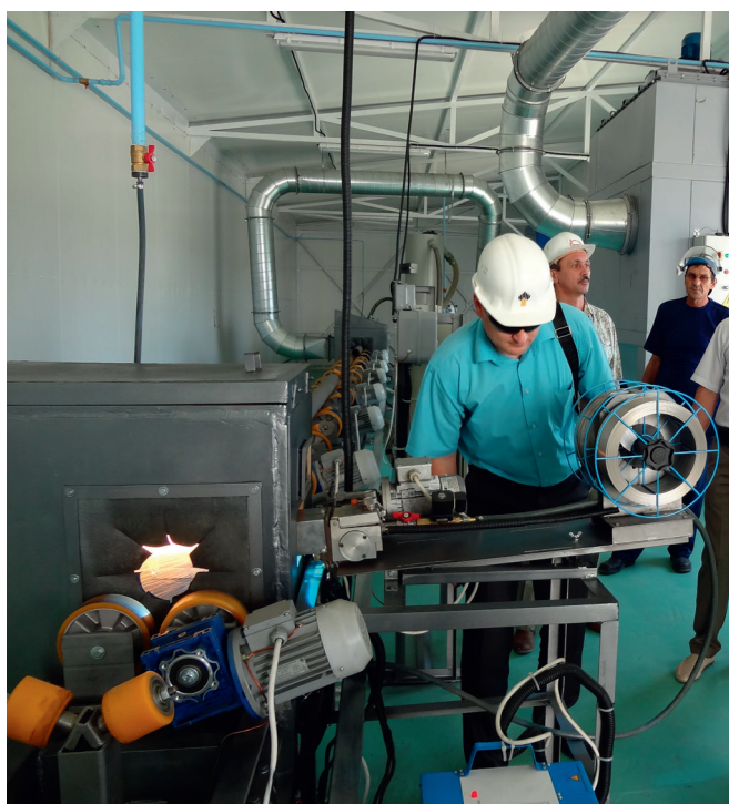
Рис. 7. Начало процесса нанесения покрытия из нержавеющей стали на корпус УЭЦН
