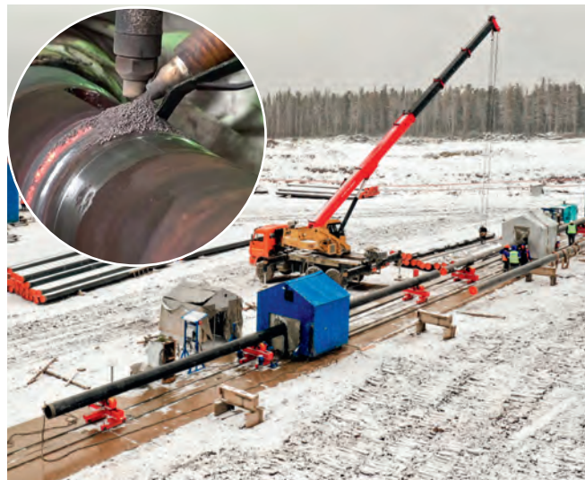
Рис. 9. Выполнение работ комплексом ПМУ-1400. Фото: ГСП-2
