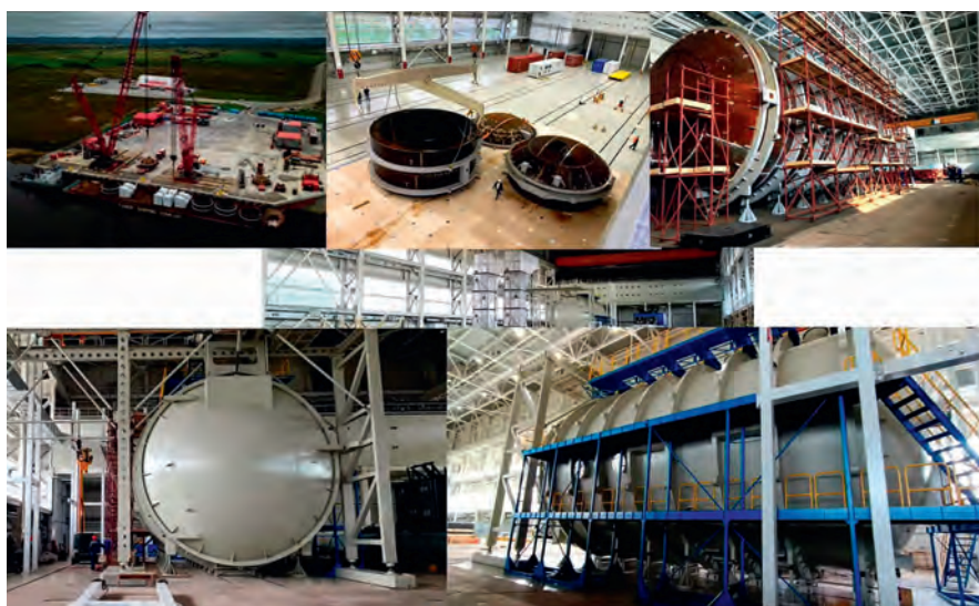
Рис. 9. Монтаж вакуумной камеры на космодроме «Восточный». Фото: АО «Вакууммаш»
