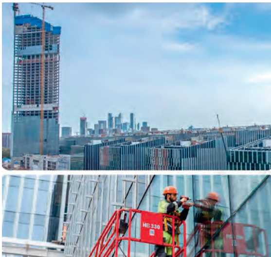
Рис. 12. Здание строящегося космического центра. Фото: Technored
