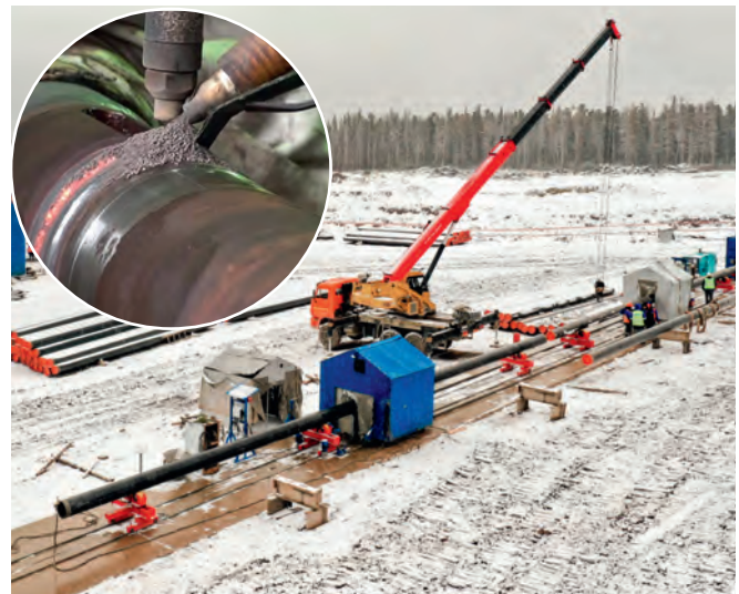
Рис. 9. Выполнение работ комплексом ПМУ-1400. Фото: ГСП-2
