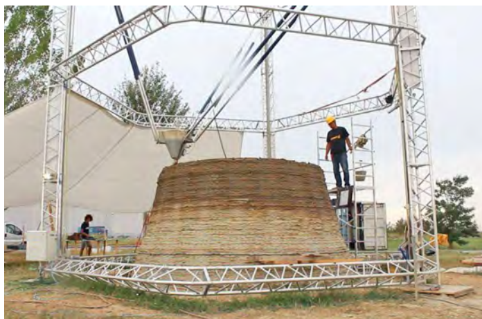
Рис. 7. Использование 3D-принтера (дельта типа) компании WASP высотой 12 м для строительства экомоды
