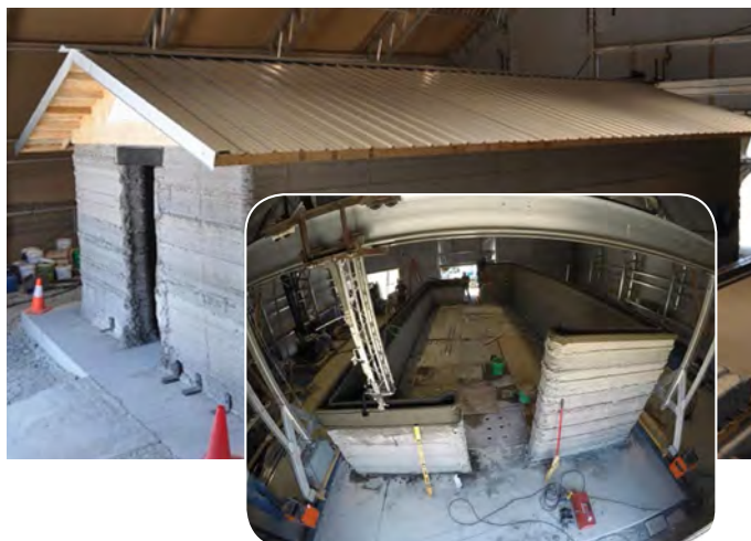
Рис. 6. Жилой блок площадью (~50 кв м) отпечатан на 3D-принтере
