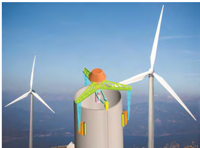
Рис. 1. Построение башни ветрогенератора по технологии Contour Crafting [1]
