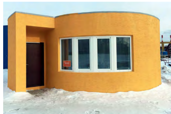
Рис. 17. Дом площадью 32 м 2 в подмосковном Ступино
